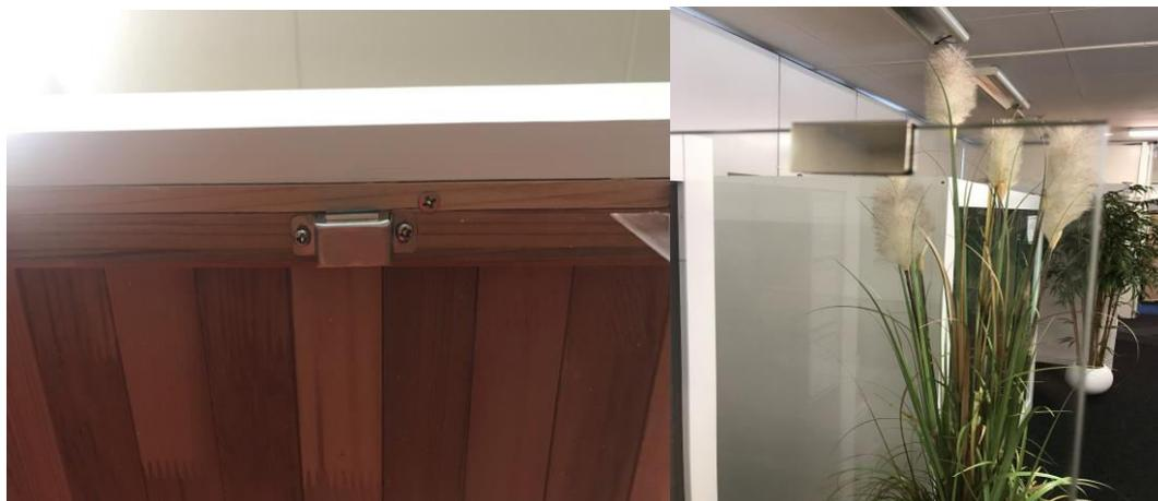
4. Montieren Sie den Magneten oben (im äußeren Drittel der Glastüre) hinter der Leiste, die zwischen den beiden Glaselementen sitzt. Setzen Sie das Gegenstück oben auf die Glastüre und schieben es in Position.
