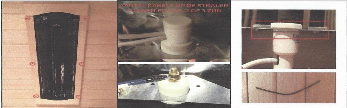
1. Nehmen Sie die schwarze Abdeckung ab, die über dem Strahler sitzt. Die Abdeckung ist mit 6 Schrauben befestigt.
